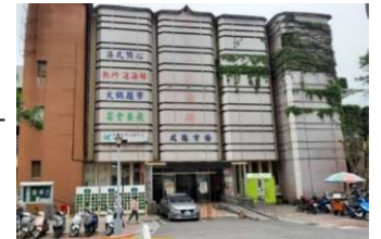
114年南港心衛中心 (內湖區及南港區) 尚在建置中...
